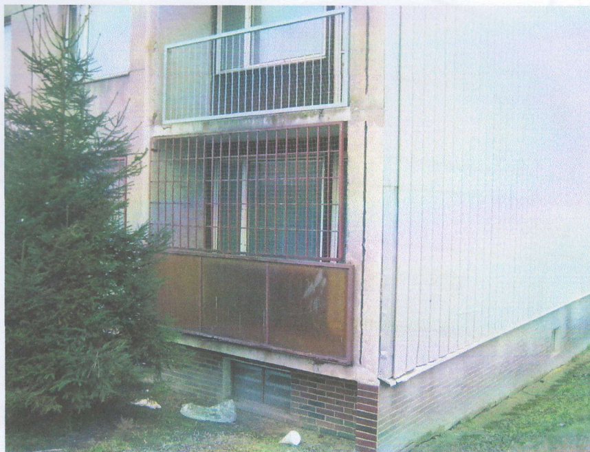
Obr. 04. Lodžie v 1.n.p. při severním štítu je chráněná ocelovou mříží. Štít je obložený dodatečným tepelně izolačním štítem FEAL. Hlavním důvodem byla eliminace zatékání dešťové vody spárami štítu.
