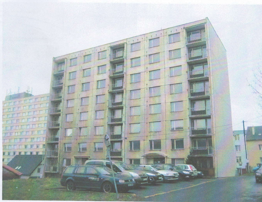
Obr. 01. Východní průčelí s hlavním vstupem do budovy a severní štít s tepelně izolačním obkladem.
