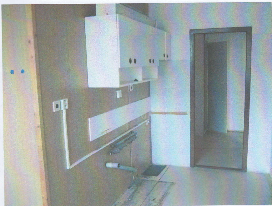
Obr. 07. Kuchyňské linky jsou částečně demontované
