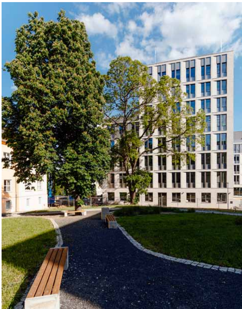
Ve vyšší části má objekt devět nadzemních podlaží – respektuje ráz původní nemocnice, díky jeho tvaru vznikly v areálu nové parkové zóny
