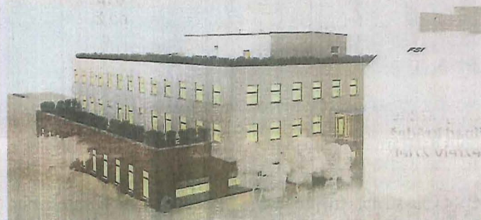
BUDOVA CEMMTECH v areálu kampusu UJEP na Klíši. Foto: Archiv UJEP
