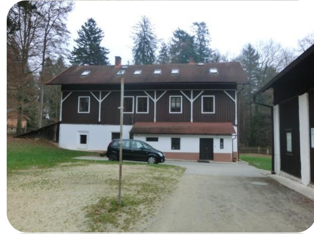
hlavní a vedlejší budova
